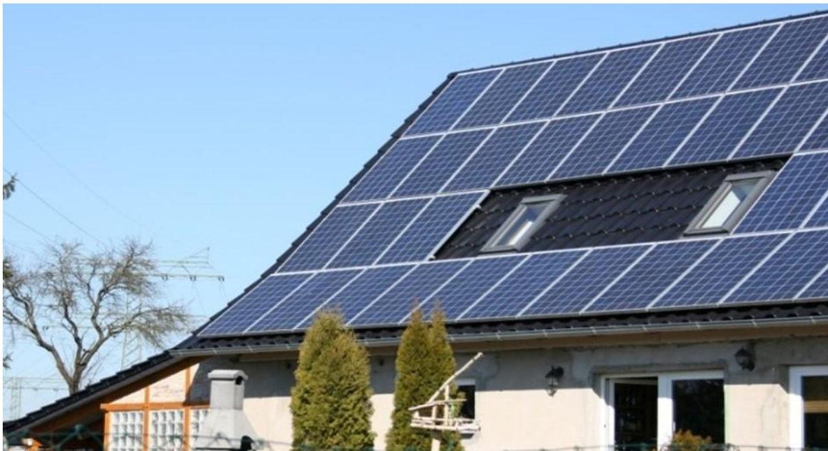
Abb. 11: Beispiel für eine gelungene Dachneigung
